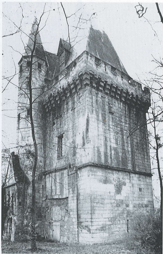
2) Saintines . Façade sur cour et flanc extérieur de la tour-porte : trace de l'issue charretière murée et, à côté, du raccord de la courtine supprimée (Ph. Ch. Corvisier).
