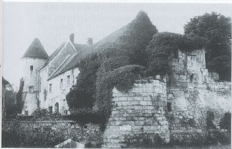
7) Ansacq . Tour d'angle et amorce de la courtine postérieure de la maison-forte avec mâchicoulis (Ph. Ch. Corvisier).
